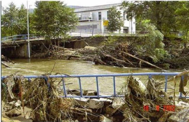
Abb. 3: Schäden und Versatz durch Treibholz nach dem Augusthochwasser 2002 im Gewässerabschnitt Nickelhütte Aue GmbH/ Foto: F. Gilardoni/StUFA
