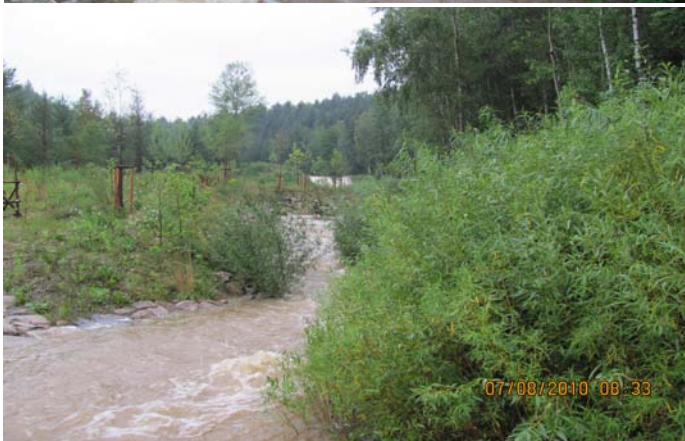
Gewässerprofil bei HW - Abfluss / rechts Weidenspreitlage 2.EW
