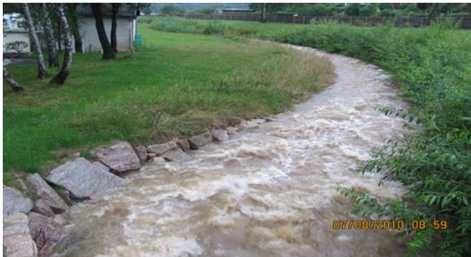
Augusthochwasser 2010 Begrünte Krainerwand im Prallhangbereich bei HW – Beanspruchung
